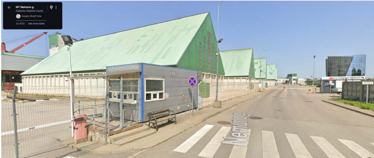
4.2.7 pav. UAB „Birių krovinių terminalas sandėliai, dešinėje - administracinis pastatas.
